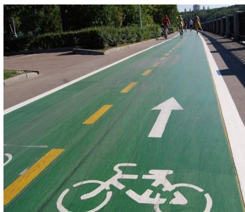
1.3-rasm. Oddiy asfalt yuzani bo'yash orqali rangli qoplama hosil qilingan a) piyodalar o'tish joyi b) velosiped yo'li [7].
