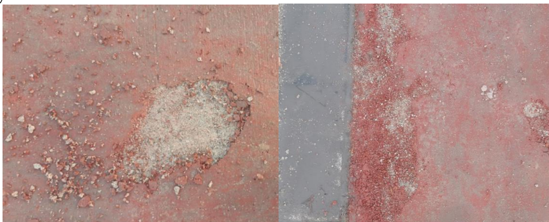
3-rasm. Sement beton asosida rangli yo'l qoplamalarining muzlab erish ta'sirida buzilishi.
