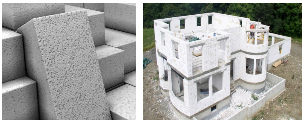
Рис.1. Внешний вид газобетона и здание, выполненное из газобетонных блоков.
