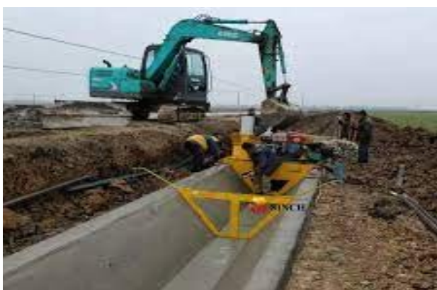
1-rasm. Kanallarni betonlashtirish jarayoni.
