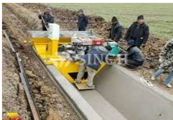
1-rasm. Kanallarni betonlashtirish jarayoni.
