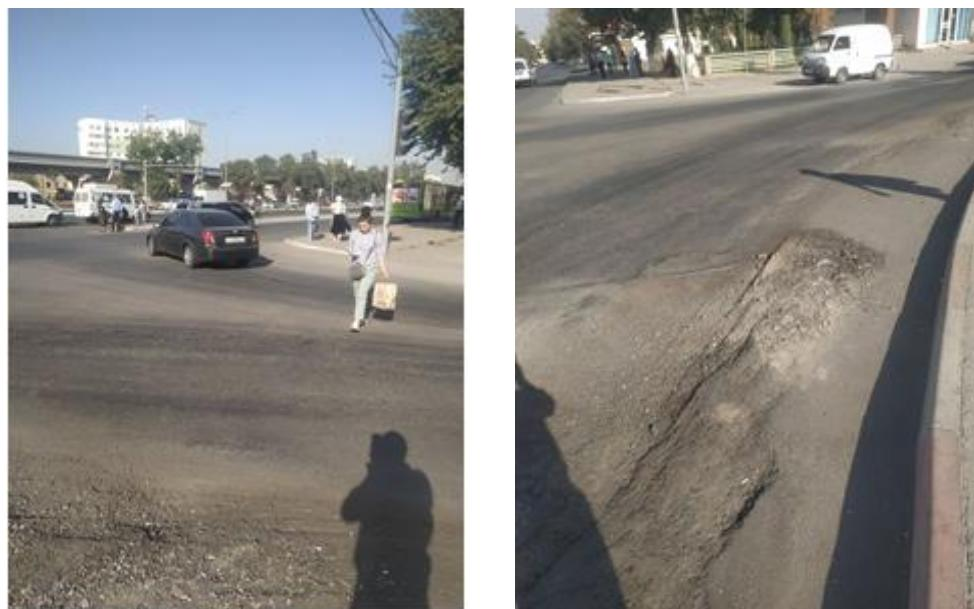
**Рисунок 4. Дорожные линии 1.14.1, 1.14.2 и 1.14.3 для пешеходных переходов отсутствуют.**
