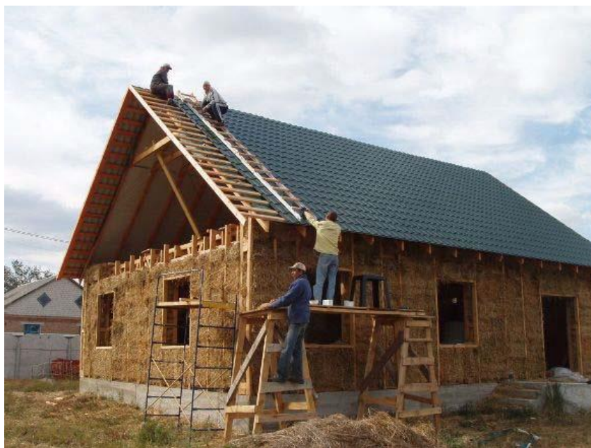
Рис. 1. Строительство дома по технологии укладки соломенных блоков в каркас
