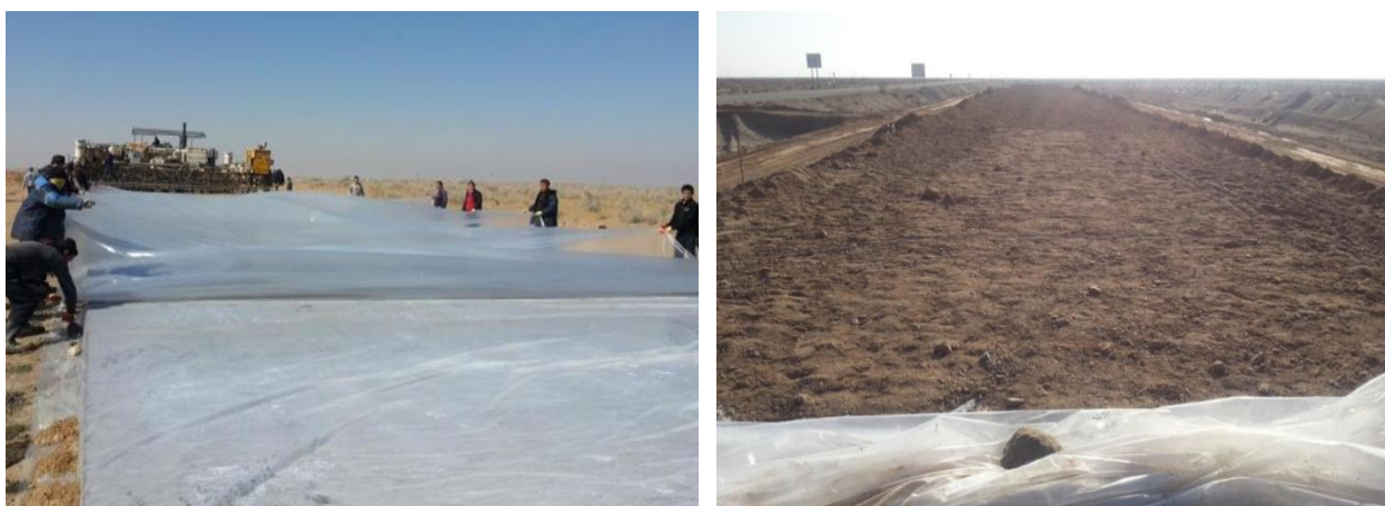
Рис. 1. Последовательность работ, выполняемых для поддержания укладываемого покрытия при высоких температурах
