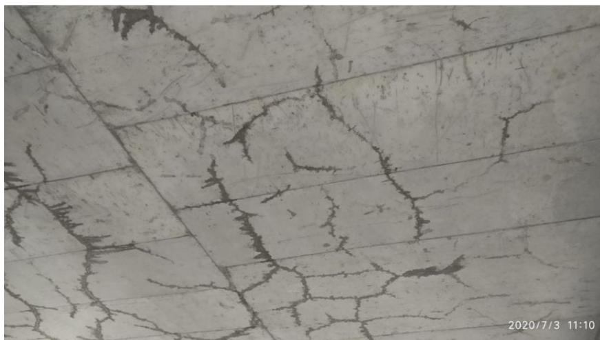
Рис.1. Фрагмент поврежденной части монолитной плиты железобетонного балочного перекрытия
