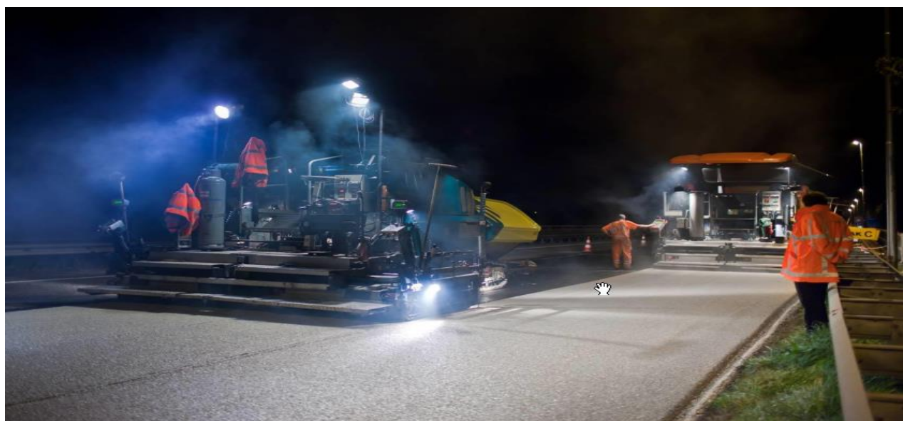
4-расм. Рангли асфальтнинг ётқизилиши
